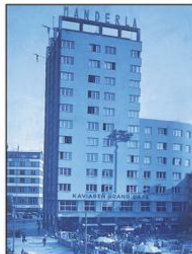
Budova podnikateľa Rudolfa Manderlu, populárny „Manderlák“ postavený roku 1936. Prvá výšková budova v Bratislave.
