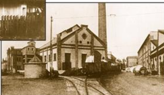
Továrňu na káble v Bratislave
